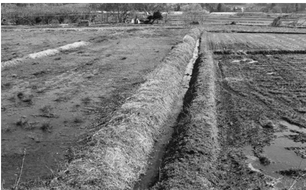
用排水兼用の土水路
