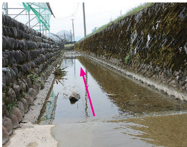
下流部底盤コンクリート未施工区間の状況
