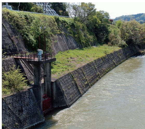
新堰頭首工 右に最上川、左上に県道23号天童大江線
