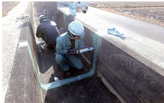
目地補修工事の様子（写真は谷地堰幹線用水路）
